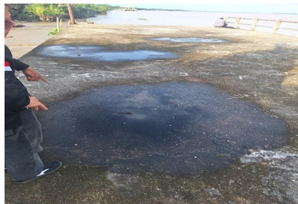
Gambar 7. Genangan air pada permukaan dermaga
