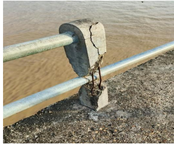
Gambar 2. Retak beton
