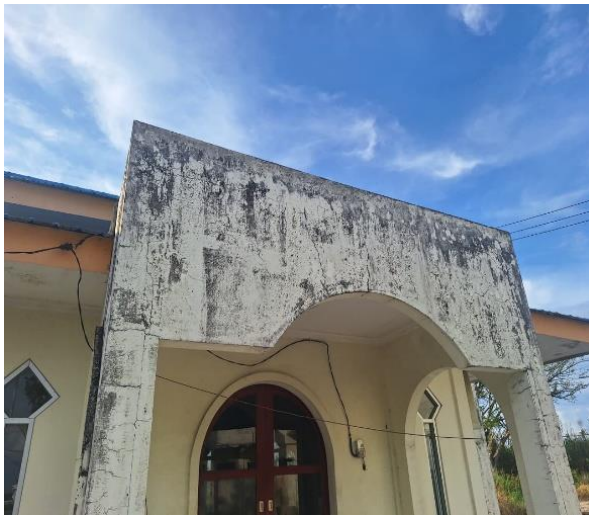
Gambar 8. Pengelupasan lapisan cat
