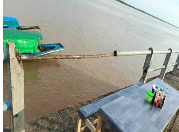
Gambar 5. Pipa pagar diganti kayu
