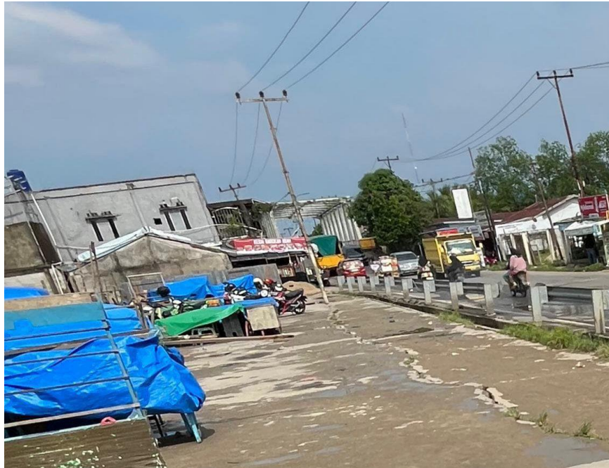
Gambar 5. Ada Kertakan Pada Permukaan Lantai
