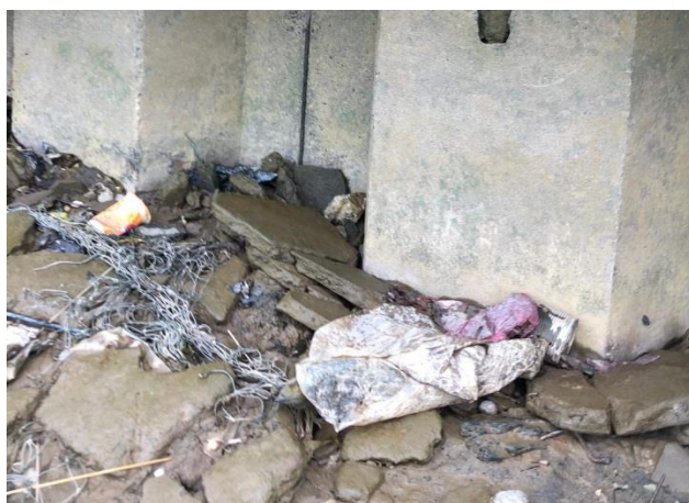
Gambar 4. Penurunan Tanah Di Bagian Bawah
