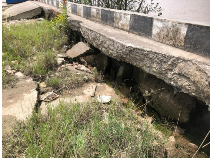
Gambar 3. Penurunan Tanah Bagiam Atas
